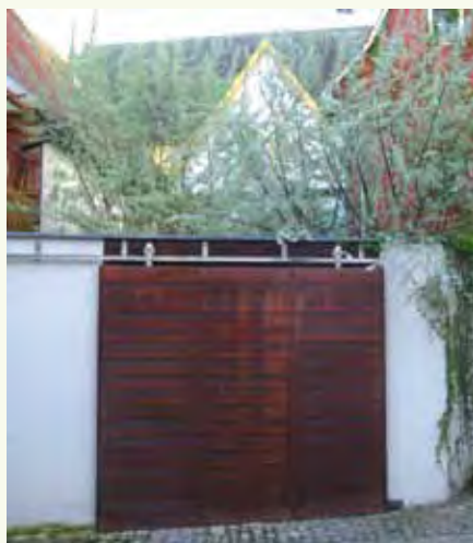
Zeitgemäße Lösungen von guter Qualität, wie das Schiebetor aus Cortenstahl, fügen sich ganz selbstverständlich in das Umfeld ein.
